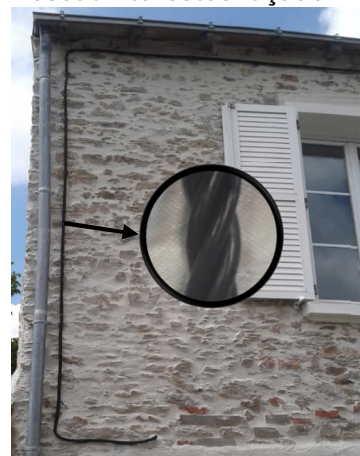
Réseau fils isolés façade BT
